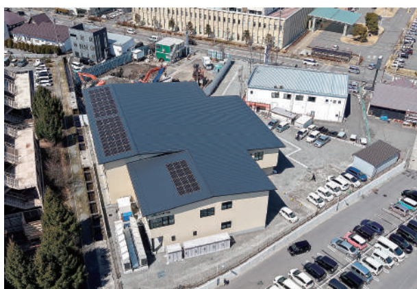
ＪＡあづみ 防災拠点施設（本所・豊科支所）
